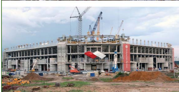
Рис. 1 Общий вид строящегося стадиона
